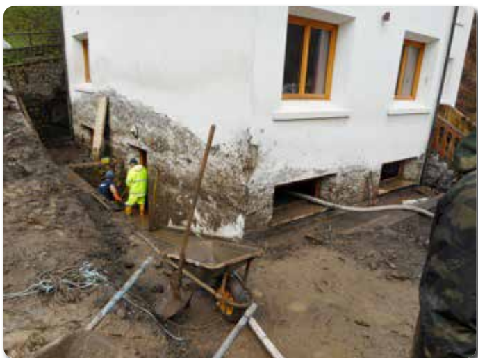
Uno scatto che immortalava i lavori in corso: ben visibile la devastazione causata dalla piena delle montagne bellunesi
