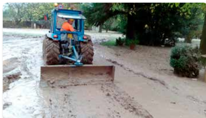
I lavori in corso per la pulizia dopo la piena di fine ottobre
