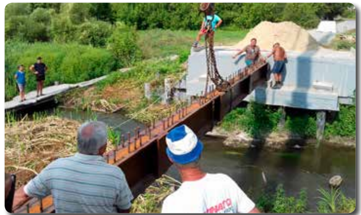
Un momento dei lavori di realizzazione del ponte
